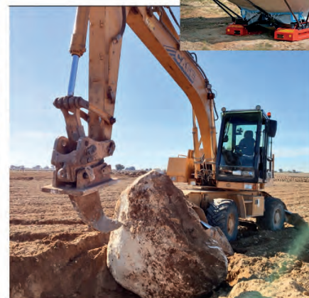
Despedregado y Extracción de piedra con excavadora
